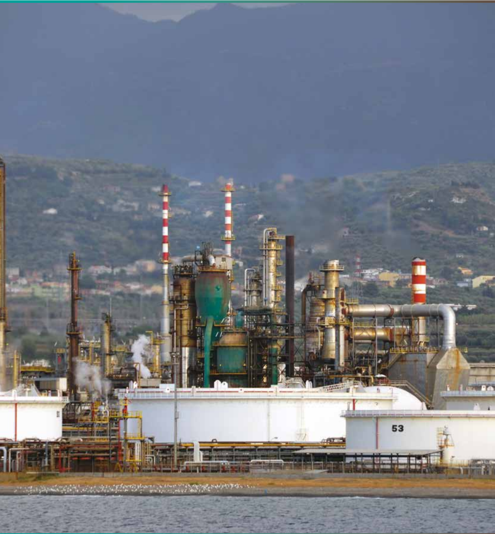
Foto 10.20 Impianti industriali Fonte MATTM Luca Grassi
